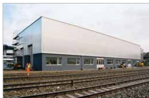
Façade Sud, en chantier
