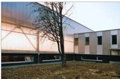
Façade Nord, angle halle et ateliers-bureaux
