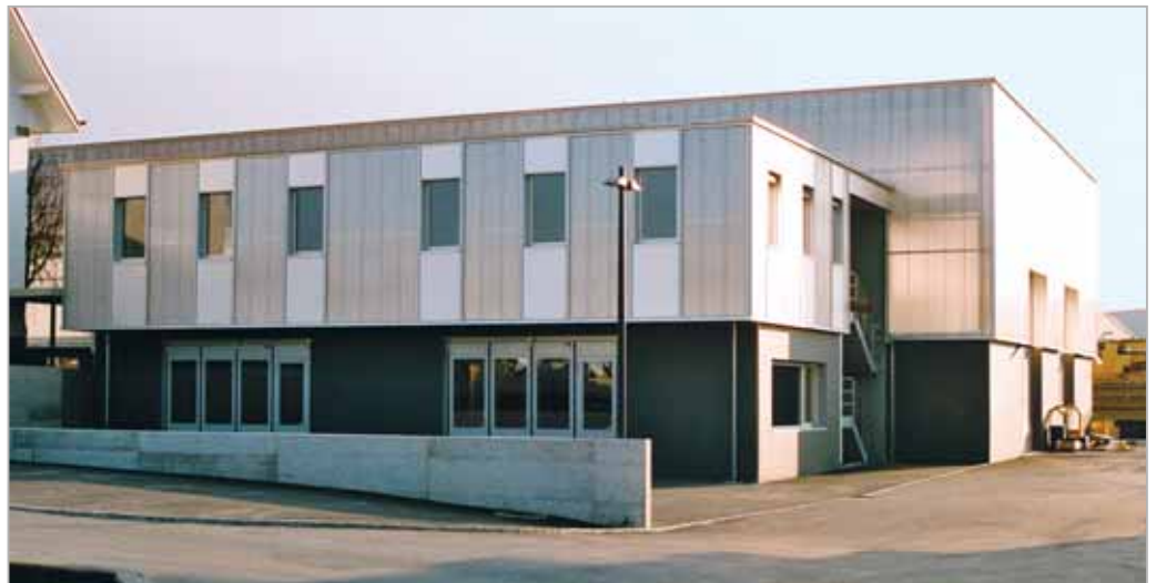
Volume ateliers-bureaux et halle
