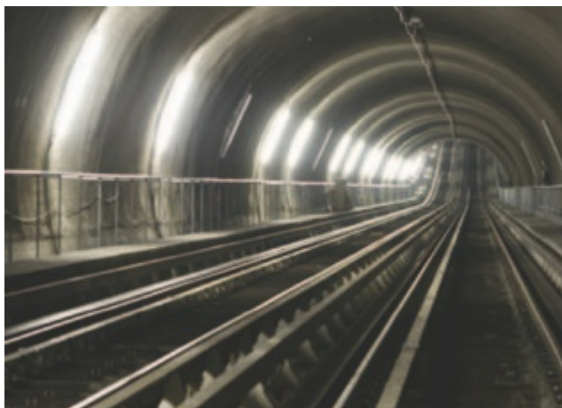
4: Le tunnel de la route de Berne.
