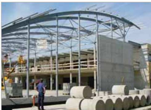
Lien entre le métal et le béton
