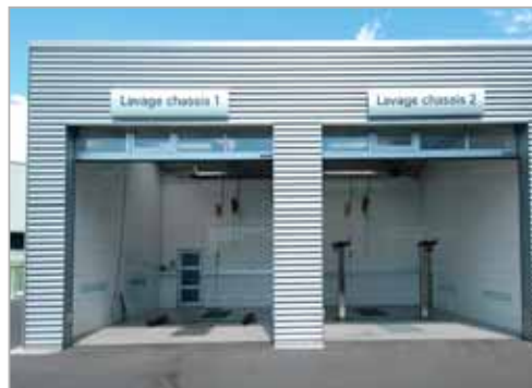
Traitement de façade différent à l'arrière du bâtiment
